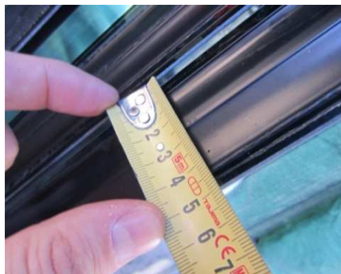
Vetrare triplo vetro basso emissivo. Serramento a taglio termico SCHÜCO
