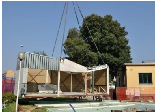
VeluxLAB: inizio del cantiere
